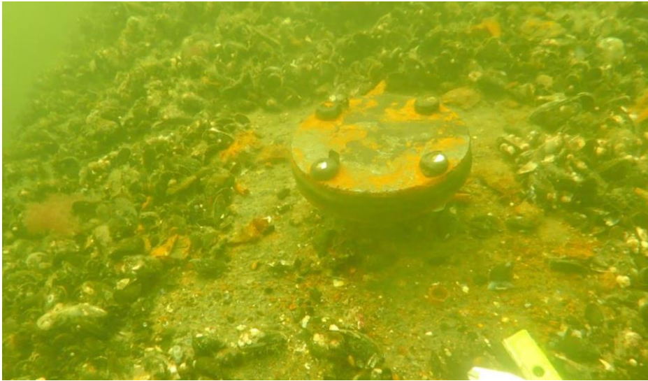
Figur 4-3. Musslor på befintlig utloppsledning. Bild från Tyréns (2022).
