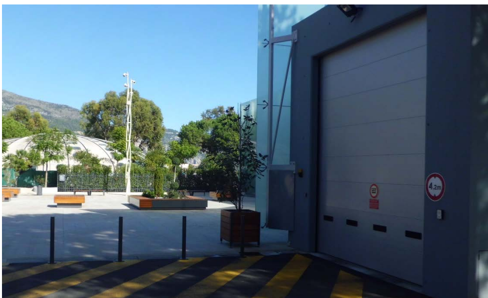
Figur 10. Nedfart till reningsverket i Rouqebroun.
