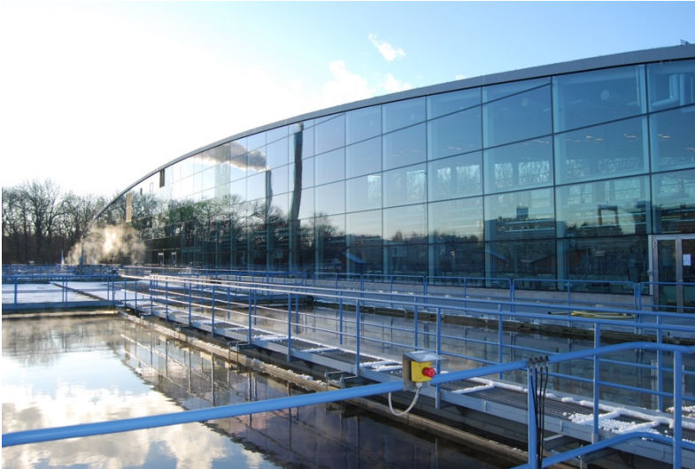
Figur 2. Skivfilteranläggning i Göteborg. Foto Ulrika Wahlström (tillgänglig via www.gryaab.se ).
