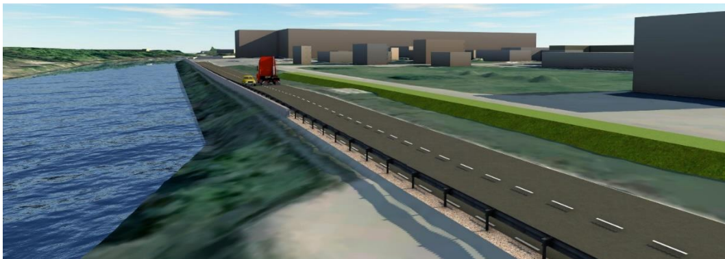
Figur 2 Visualisering av översvämningsskydd längs Nordreflintsvägen, vy från nordöst. Längs södra delen av Nordreflintsvägen föreslås en betongmur, betongmuren övergår i en jordvall öster om vägen. I samband med högvatten behövs tillfälliga översvämningsskydd för att knyta samman muren och jordvallen.
