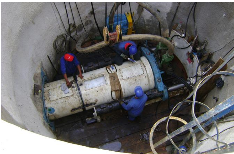
Figur 5-5 Pipe jacking (bild Wikimedia Commons)
